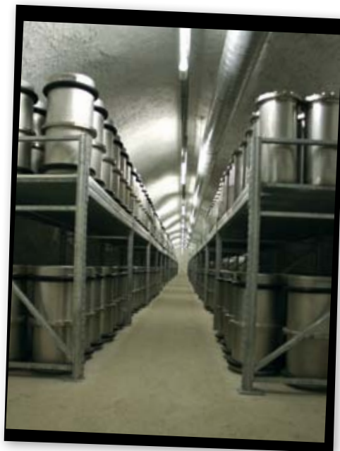
Lagerraum im Barbarastollen
