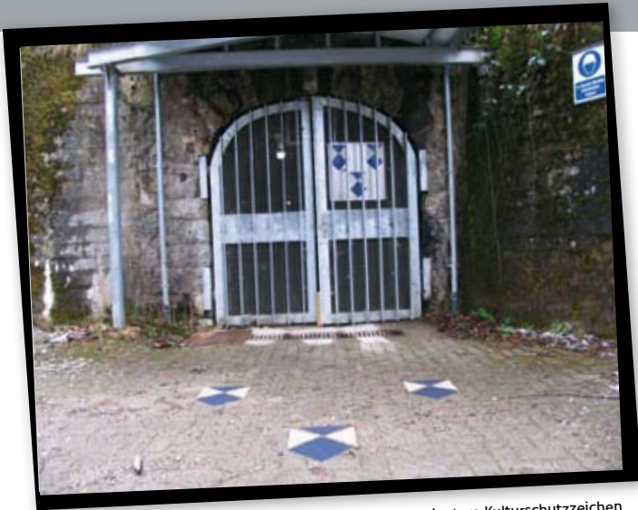
Barbarastollen in Oberried – Eingang mit dreifach angeordnetem Kulturschutzzeichen
