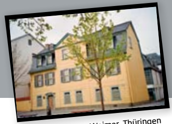
Schiller-Wohnhaus, Weimar, Thüringen
