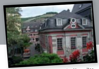
Altes Rathaus, Bad Neuenahr-Ahrweiler, Rheinland-Pfalz
